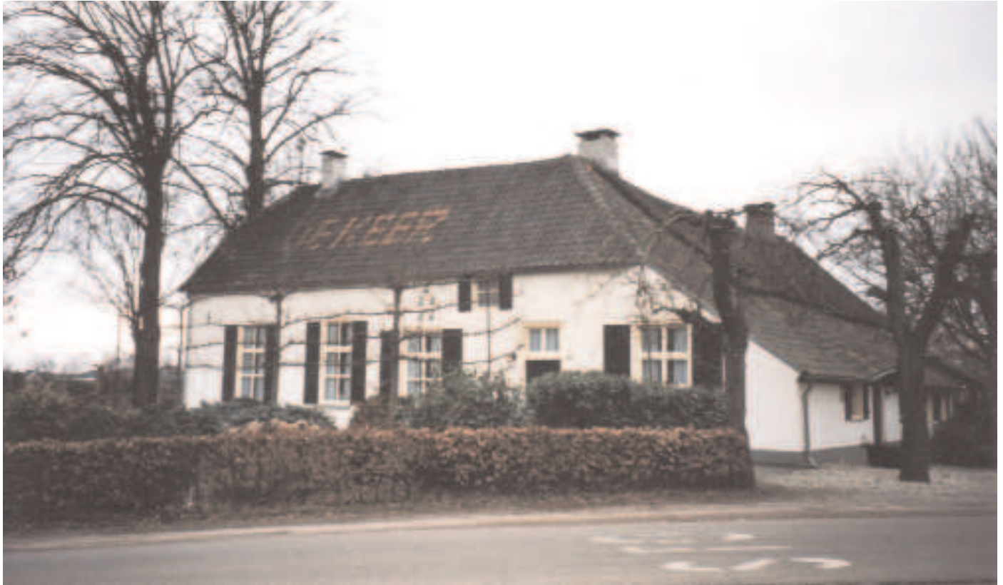
Boscheweg 60 met in het dakvlak "De Keer". In 1731 werd Peregrina hier te vondeling gelegd.
